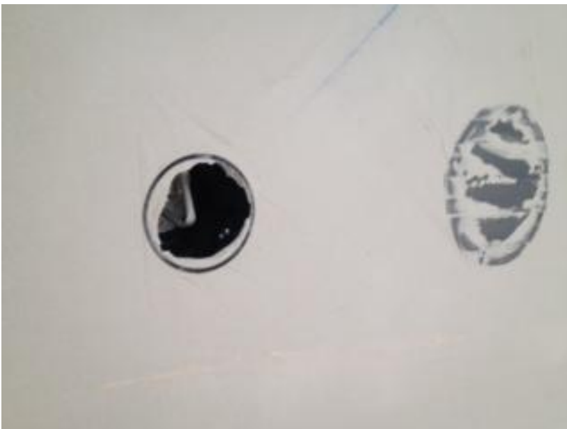
Loftsudtag samt afdækket ventilationsrør
