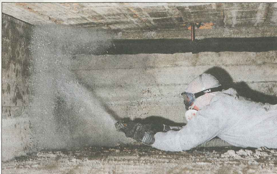
En wet-spray af lim og papiruld kan bruges til at efterisolere krybekældre på minimum 60 cm eller højere med en tætsluttende isolerende flade uden utætheder og kuldebroer
