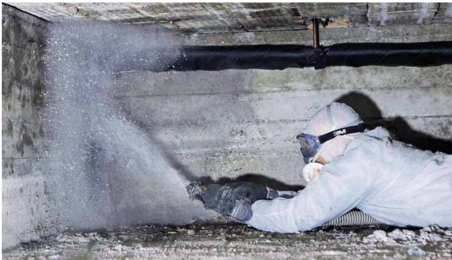
Isolering blandet med lim og vand sprøjtes på vægge og loft i krybekælderen.
