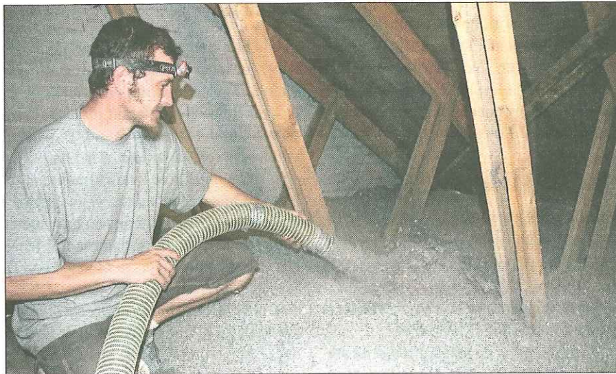
Papiruld blæses ind med højt tryk med en slange. Dermed undgår man at bære materialet gennem huset.
