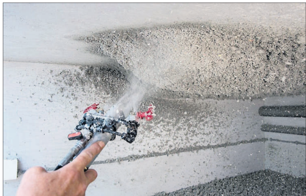
Krybekældre. Et isoleringstjek kan vise, om det med fordel kan svare sig at udskifte eksisterende isolering med helt ny isolering.
