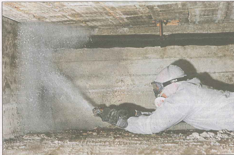
En wet-spray af lim og papiruld kan bruges til at efterisolere krybekælder på minimum 60 cm eller højere med en tætsluttende isolerende flade uden utætheder og kuldebroer.
