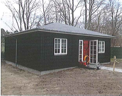
Klar til Blowerdoortesten på et af husene på Rørvig Feriecenter.
